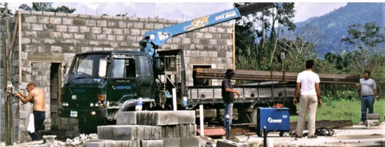
Grupo de construcción de Castle Rock, Washington y trabajadores de Honduras construyendo el hogar de niños en Tegucigalpa en el 2003
