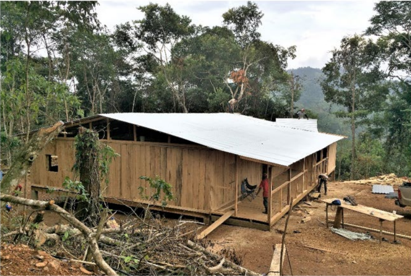
La Finca, Construyendo una cabaña en la plantación de café, en las montañas de Santa Barbara
