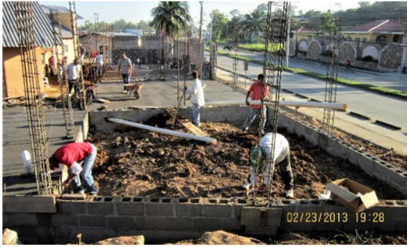
Construyendo la escuela bilingüe Mary Frenter en Puerto Cortes 2012
