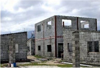
Casa de niños en construcción
